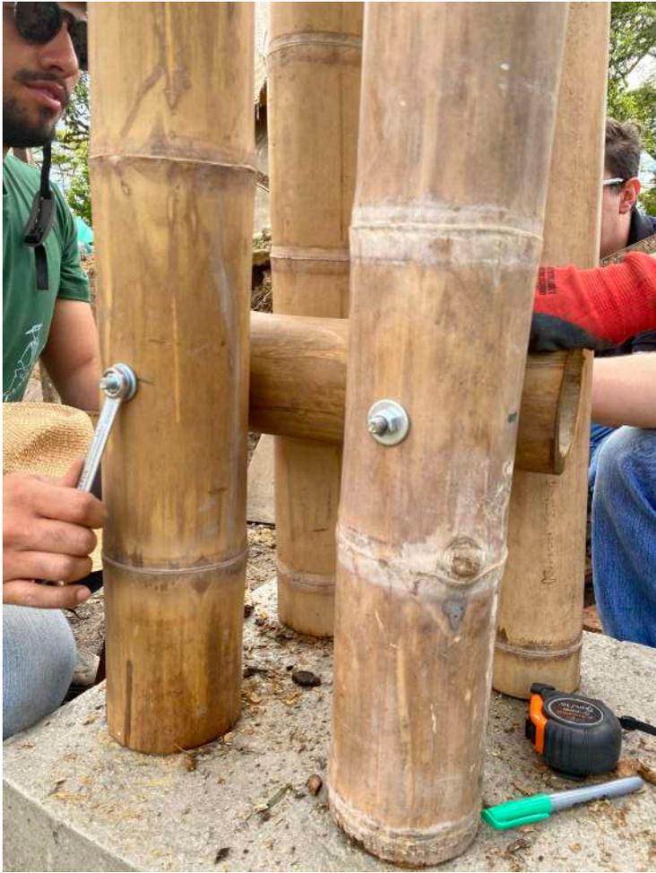
Un total de 16 personas participaron en el taller, y se logró completar la construcción de un módulo en bahareque con dimensiones de 2,00 x 1,50 metros, así como la creación de un soporte estructural utilizando guadua.
