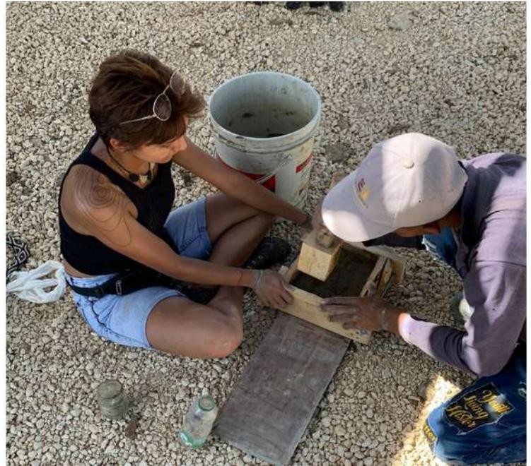
La construcción de los dos módulos de formaleta es un proceso que se desarrolla de principio a fin durante la capacitación. Esto se hace para comprender el nivel de complejidad que conlleva, ya que deben ser capaces de resistir las fuerzas generadas durante la compactación del muro.
