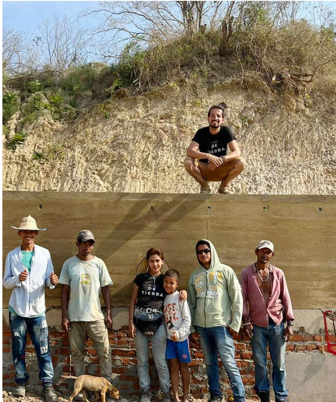
Para el desarrollo de este muro, se extrajo tierra de un terreno cercano al proyecto. Se llevaron a cabo pruebas de identificación para comprender el comportamiento del material y determinar la estabilización adecuada en la técnica de la tapia pisada. Todos estos procesos se realizaron en colaboración con la mano de obra local, con el objetivo de familiarizarse con los diferentes tipos de tierra que se pueden utilizar y los procedimientos de estabilización necesarios para cada uno de ellos.
