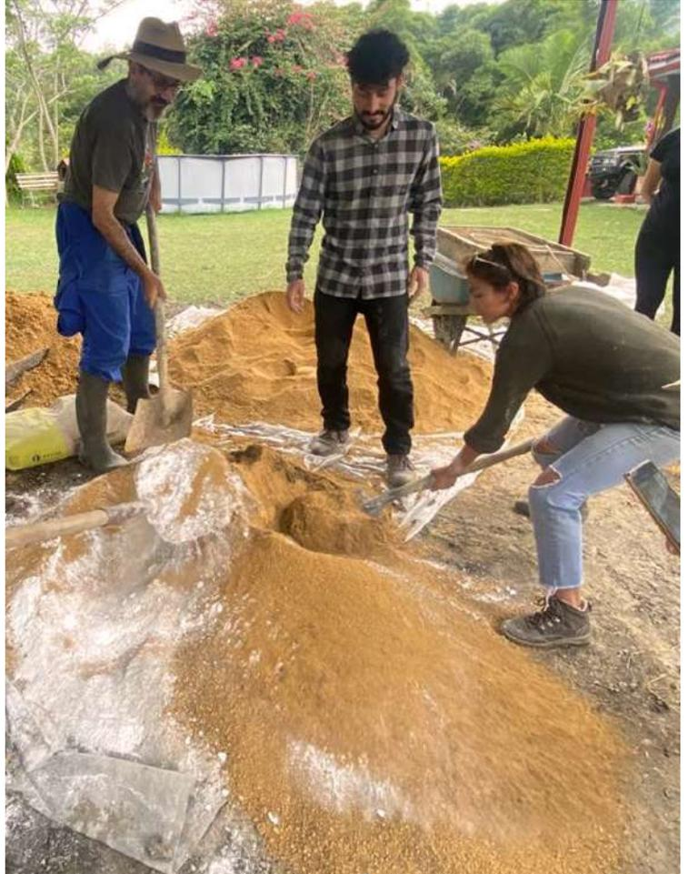
Se determina el nivel de estabilización requerido para el muro y se da inicio al proceso de preparación de la tierra y compactación del mismo. Las dimensiones del muro son de 2,44 x 1,22 metros.
