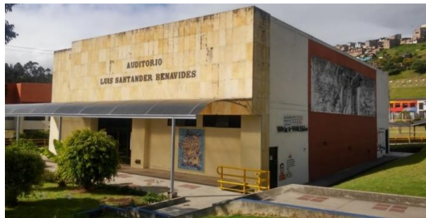
Figura 98. Auditorio Luis Santander Benavides. Universidad de Nariño – Sede Torobajo. Fuente: Equipo Autoevaluación.
