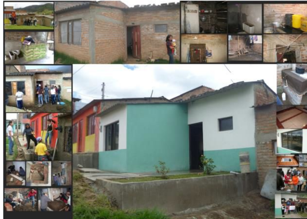
Figura 41. Intervención de acabados. Propietario: Nelly Díaz. Lugar: Barrio Aranda – Municipio de Pasto. Fuente: Archivo Departamento de Arquitectura.
