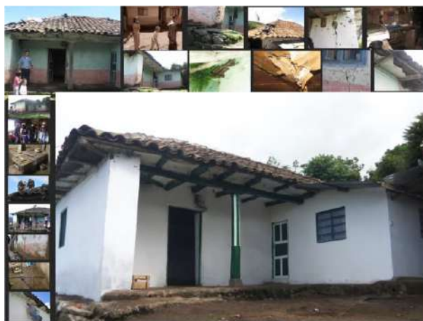
Figura 42. Intervención de edificación en tierra. Propietario: Blanca Gómez. Lugar: Corregimiento de Mapachico – Municipio de Pasto. Fuente: Archivo Departamento de Arquitectura.
